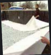
İÇ LINER DÖŞEME
